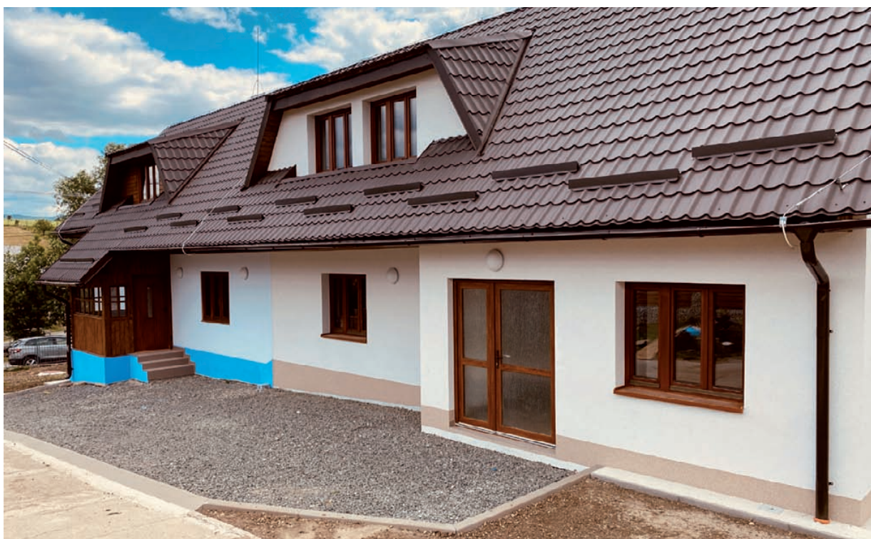
Kurov - komunitné centrum v obci
