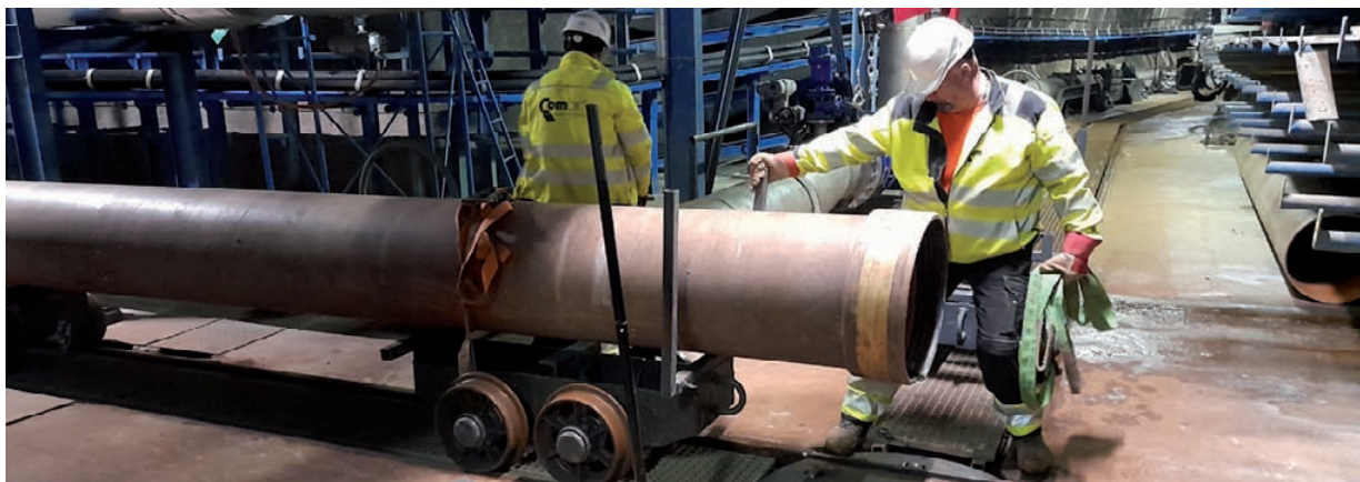
Brno, Kolektor - rekonštrukcia vodovodu
