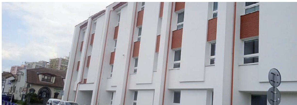
Lučenec - obnova Okresného súdu
