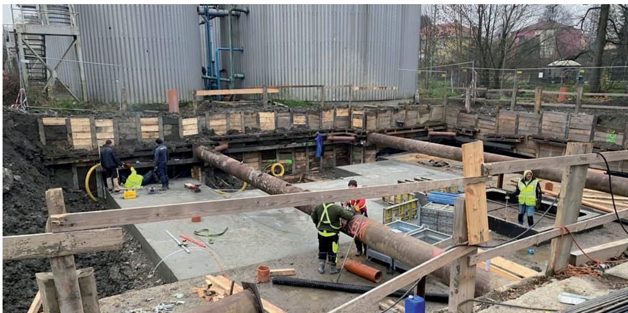
Dolní Lutyně CZ - odkanalizovanie obce
