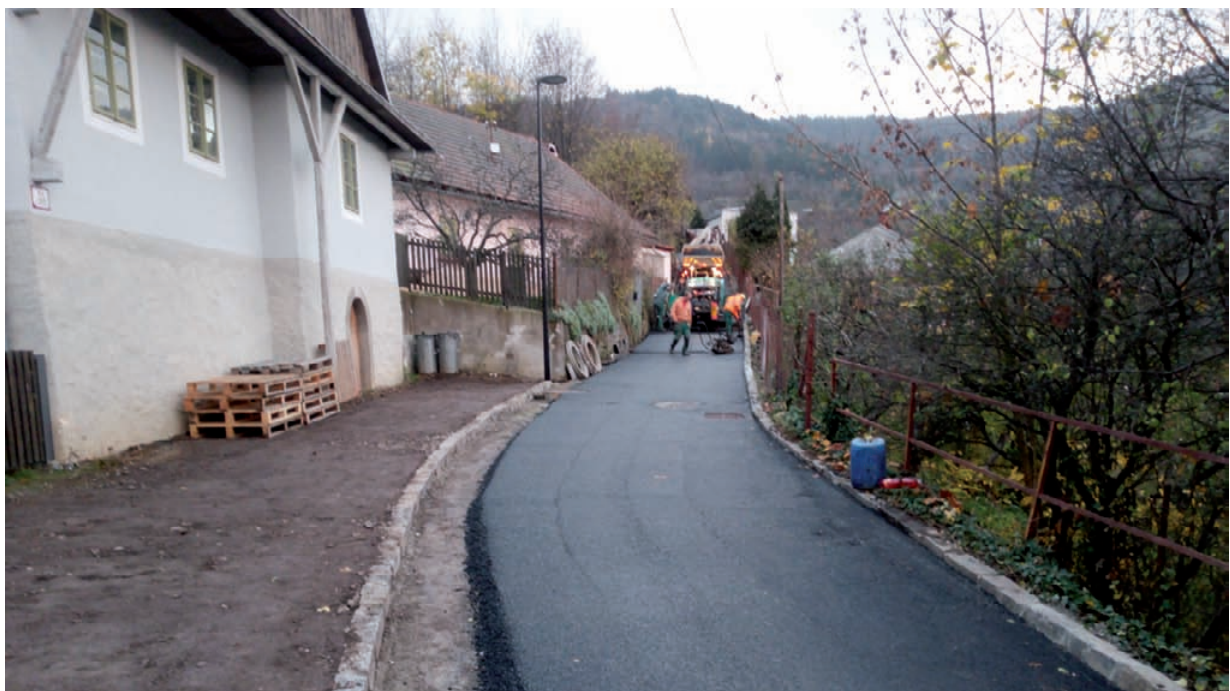
Banská Štiavnica - Dolná Resla - rekonštrukcia miestnej komunikácie
