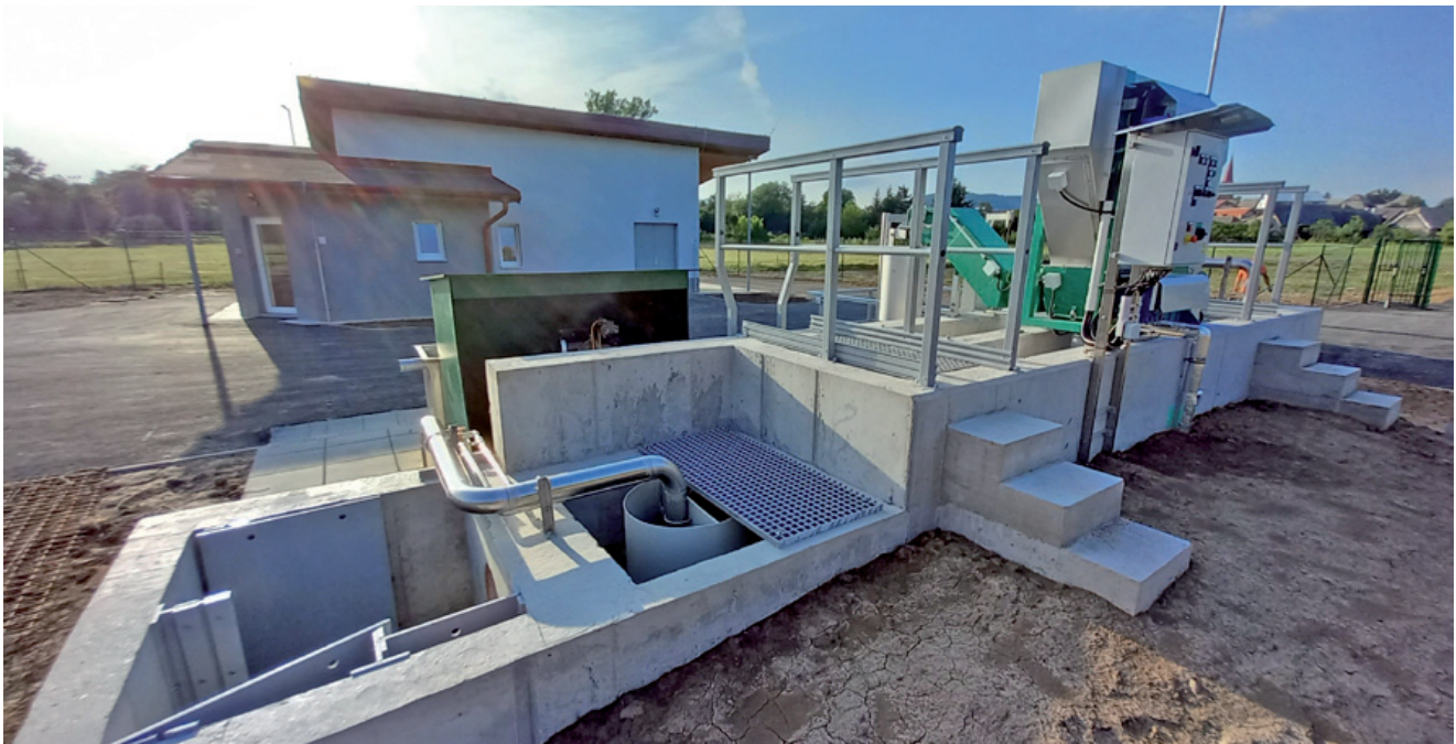
Sebechleby - kanalizácia a ČOV
