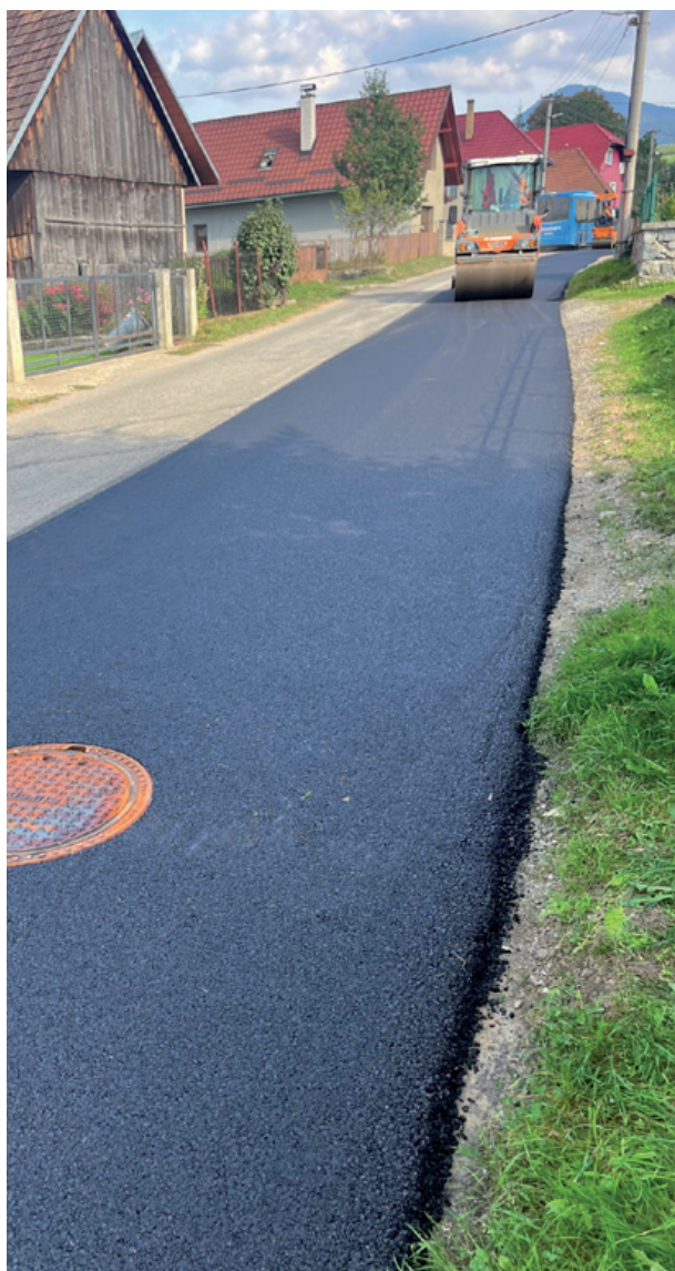
Žaškov, Orava - odkanalizovanie obcí
