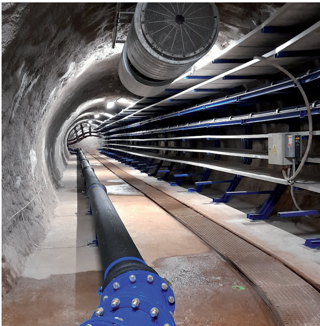
Bmo kolektor - rekonštrukcia vodovodu
