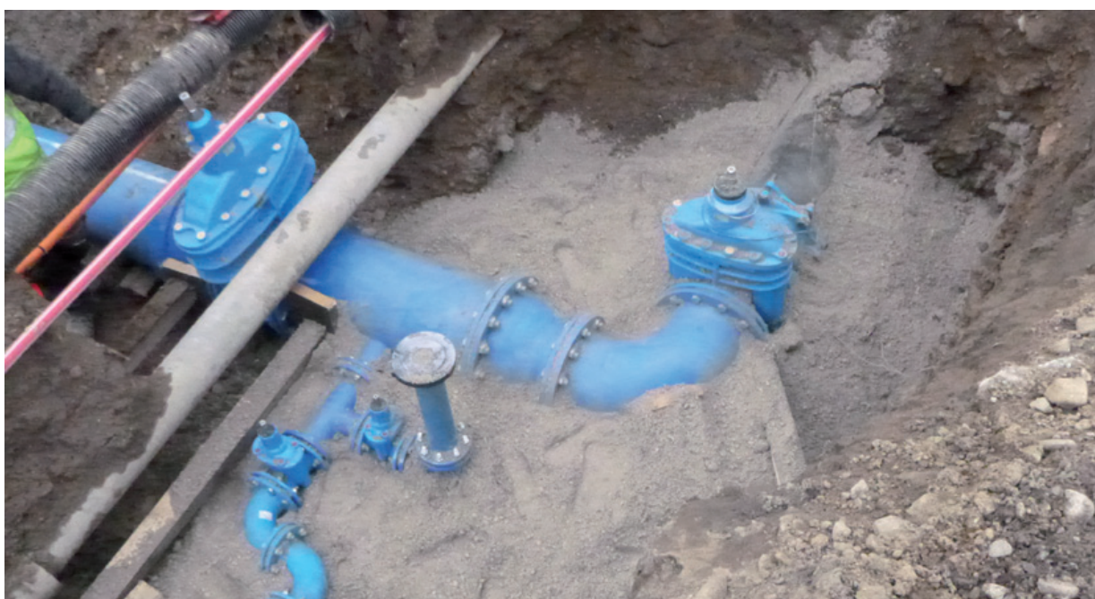
Grinava – Pezinok, oprava potrubia
