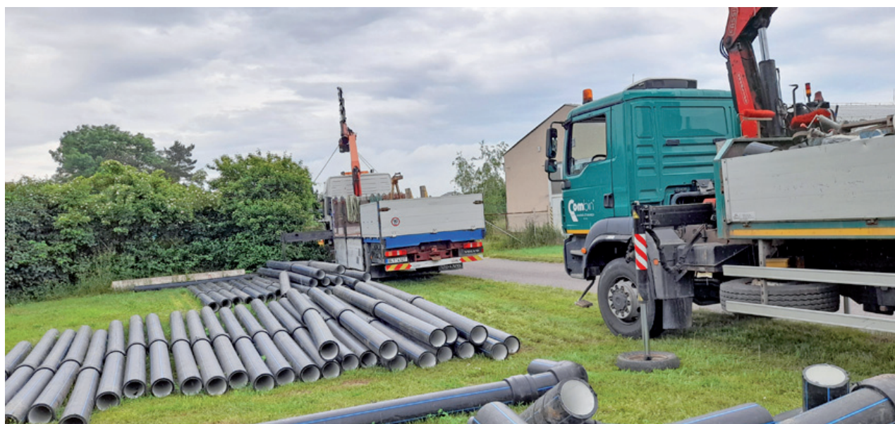
Brno kolektor - rekonštrukcia vodovodu
