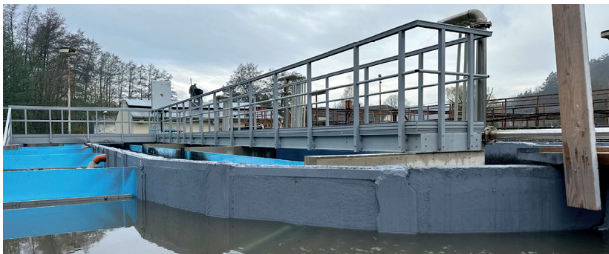
Krajné - modernizácia ČOV
